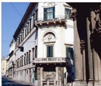
Palazzo del Drago alle Quattro Fontane Via XX Settembre Roma Ristrutturazione e ampliamento.
